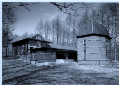
★ 八ヶ岳 エスペラント館
